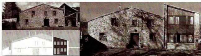
Visió de la façana principal original, proposta i vista de l'obra acabada. Font: www.bangolo.com
