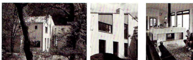
Viso del mas rehabilitat, detall façana i vista interior de la sala principal. Font: www.bangolo.com
