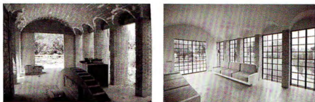
Volta catalana en fase de construcció i volta un cop acabada l'obra. Font: www.bangolo.com
