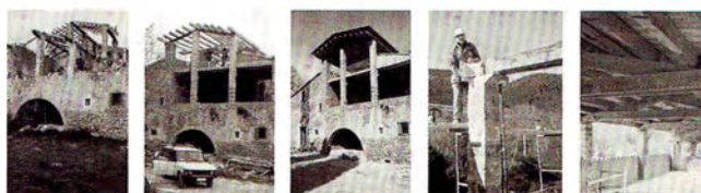
Façana original, en fase d'obres, obra acabada, detall carreus de travertí i detall encavallada.
