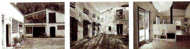
Vista del coberts originals, vista un cop acabada l'obra i aspecte de l'interior.
