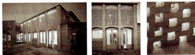
Visió general de la façana ponent, visió parcial de la mateixa i detall gelosia ceràmica.
