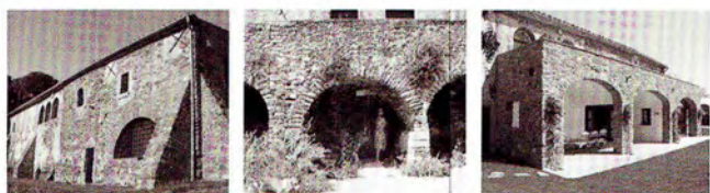
Façana original, galeria tradicional escollida com a patró i resultat final de l'obra. Font: www.bangolo.com
